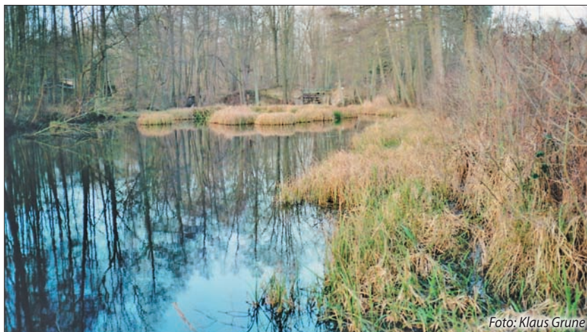
Schleuse „Hammerfort“ - Sicht auf Unterhaupt
