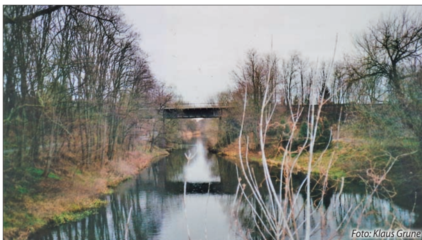
Jetzige Eisenbahnbrücke der RE1-Linie Magdeburg-Guben am Unterhaupt der Schleuse Finkenheerd
