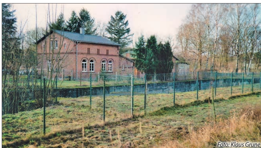
Schleuse und frisch saniertes Schleusenhaus „Schlaubehammer“
