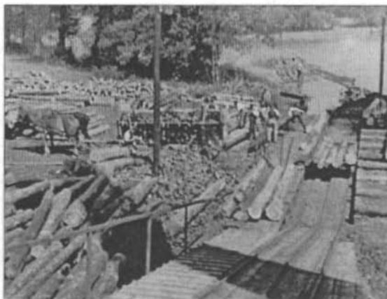
Förderung der Holzstämme aus dem See heraus
