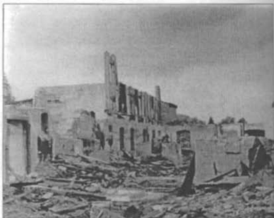
Hier wurde noch 1952 gearbeitet! Blick in den Gatterkeller mit den Fundamenten. Die Zerstörung erfolgte mutwillig
