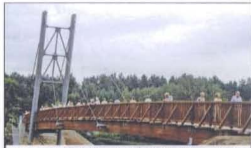
Radweg und Fußgängerbrücke 2007 in Kaisermühl errichtet
