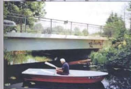
Brücke über den Katharinengraben, Durchfahrts Höhe 1,50 Meter
