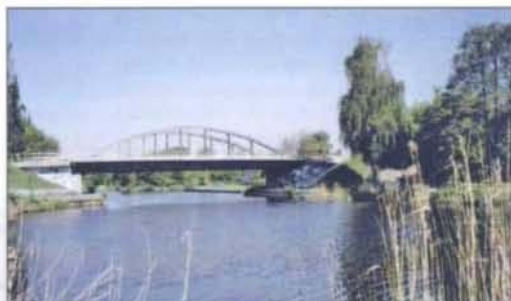
Stadtbrücke über den Oder-Spree-Kanal, Müllrose wiedererrichtet 1953
