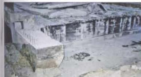
Katharinengraben-Brücke Fundament einer Panzerbrücke aus dem Jahre 1988 wurde bei Neubau der Brücke 2006 belassen und ermöglicht nur 1,50 Meter Durchfahrts Höhe
